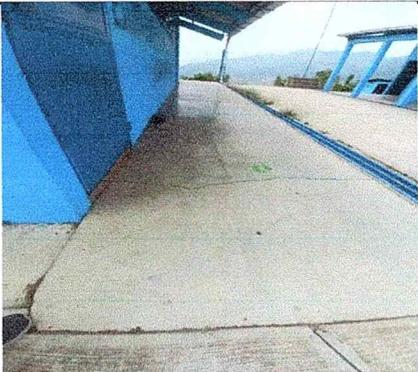
Foto 1: CORREDOR PATIO DEL AULA DETERIORO EN LA TORTA DE CEMENTO
