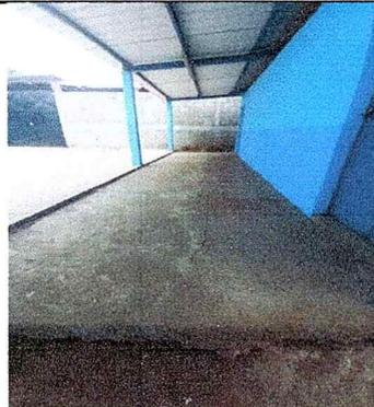
Foto 2: CORREDOR COCINA DETERIORO EN LA TORTA DE CEMENTO
